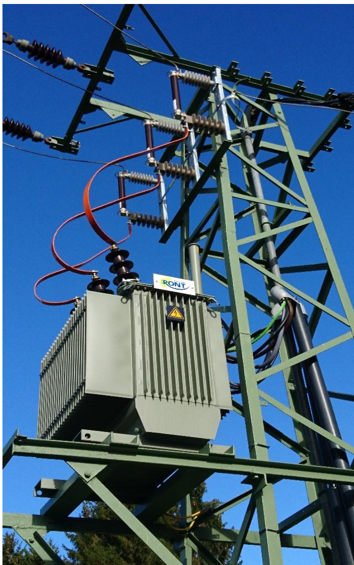
Obrázek č. 1: Olejový distribuční transformátor s OLTC
